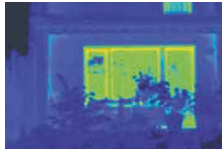
Infrarot-Aufnahme Fenster und Verglasung von OLIVA. Hier erkennt man deutlich den hohen energetischen Vorteil der Investition. Es geht nahezu keine Wärme verloren.
